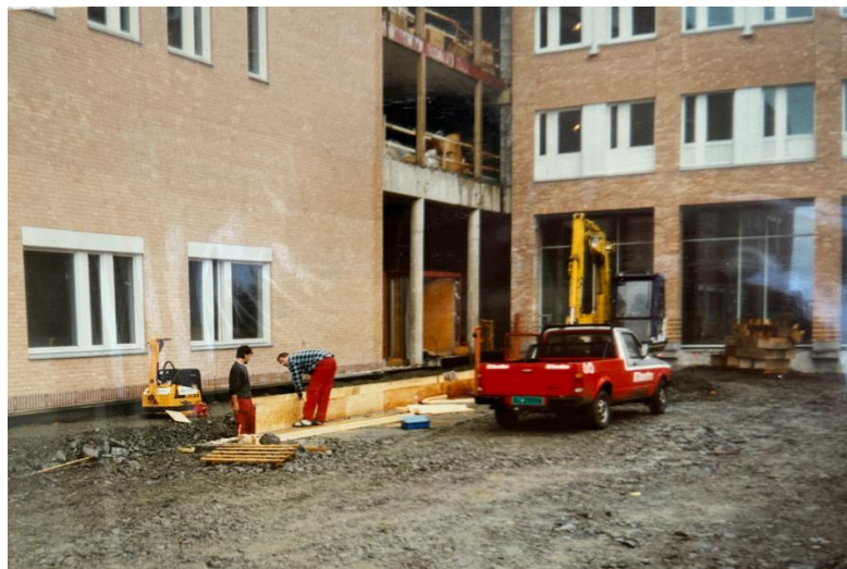
Fra bygging av Bygg E1 RH
