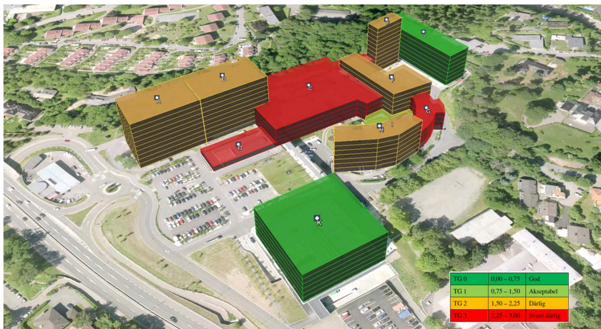
Figur 5 Oversikt teknisk tilstand Radiumhospitalet, 2014
