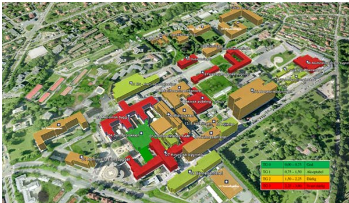
Oversikt teknisk tilstand Ullevål sykehus , 2014
